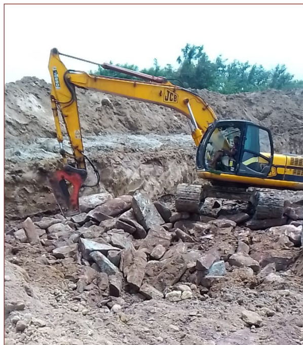
Arbeiten am Damm
