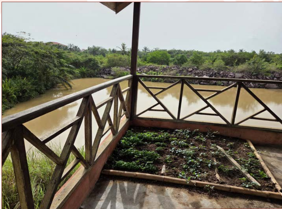
Regenwasserdamm mit erstaunlich viel Wasser für die Trockenzeit
