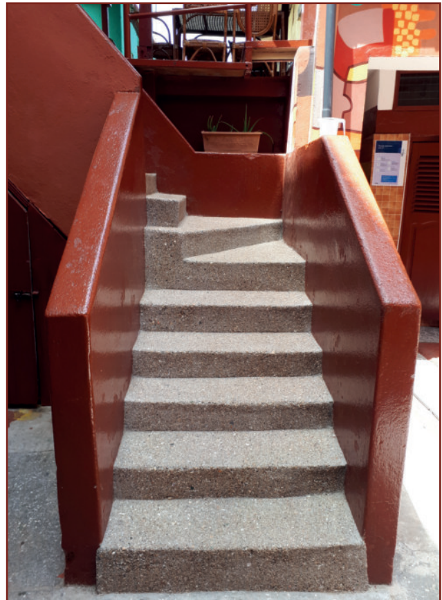
Die neu gestaltete Treppe.
