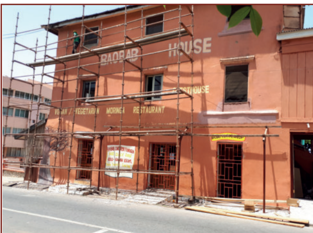
Ein ziemlich wackliges Gerüst auf das Isaac, Emmanuel und Awudu der Schreiner steigen müssen.
